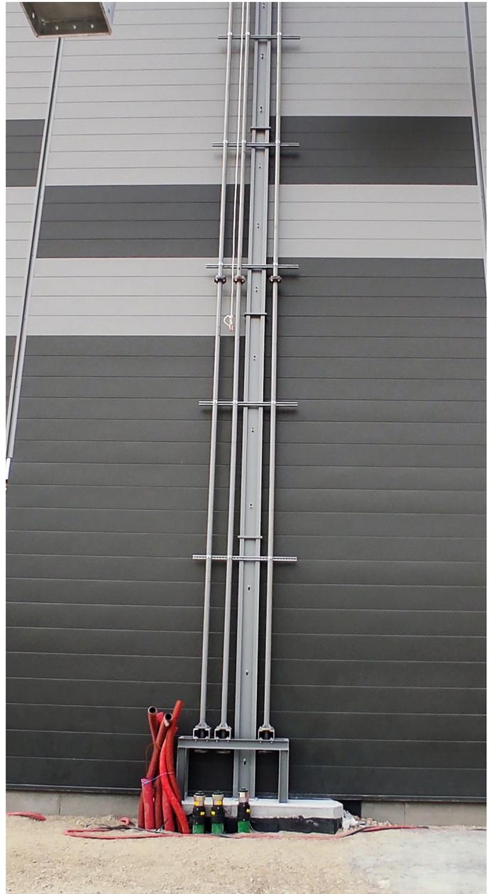
*Les tuyaux 2" KPS ont été connectés aux tuyaux acier qui montent jusqu'au toit, grâce à des raccords à bride DIN KPS, les retour mousse en 4"*
