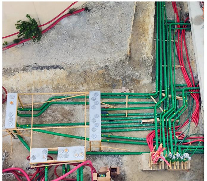
Les tuyaux KPS conducteurs évitent l'accumulation de charges électrostatiques
