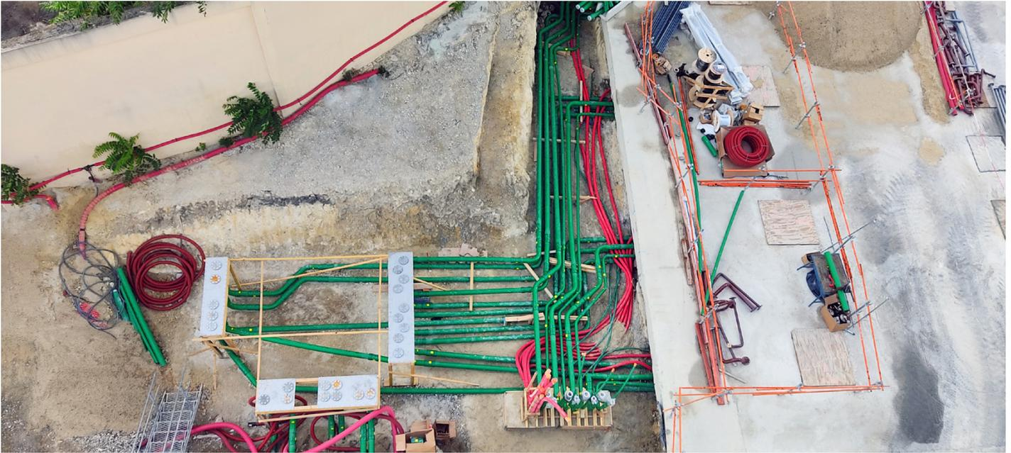
Une nouvelle tranche d'un data center autour de Paris a préconisé des tuyauteries KPS pour les groupes électrogènes de secours
