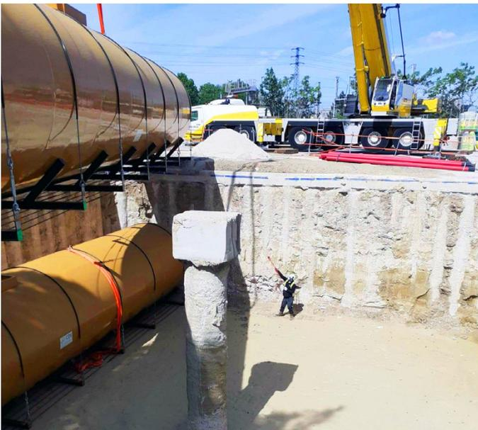
Des tuyaux 4" KPS Ø125/110 conducteurs assurent le remplissage des cuves avec un débit de 933 l/min
