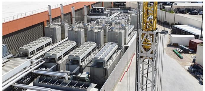
Les différentes tranches de ce data center utilisent chacune des groupes électrogènes par blocs disjoints.
