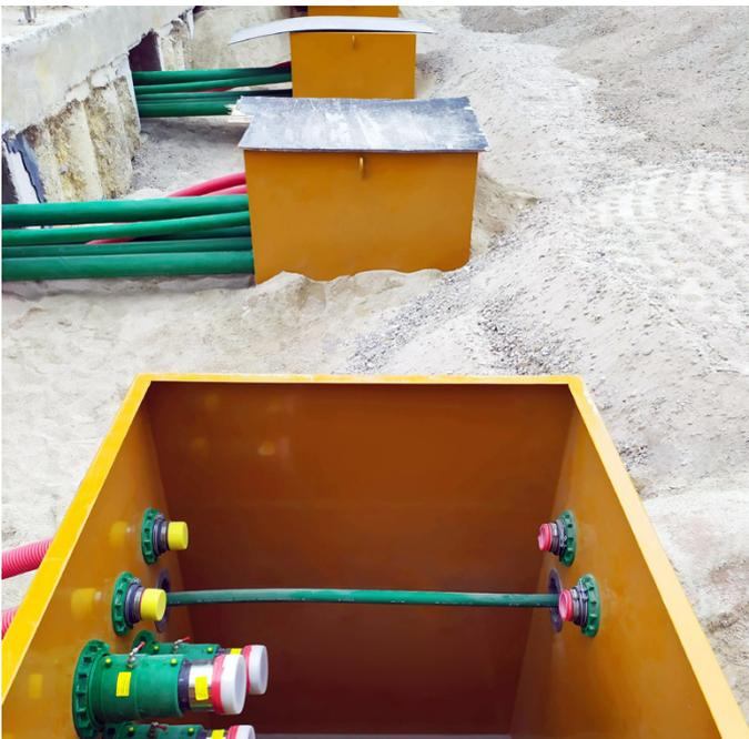
*Les tuyaux KPS 4" Ø125/110 permettent un débit de 933 l/min en toute sécurité*
