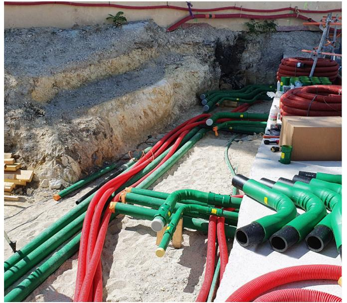
La double paroi permet de vérifier l'absence de fuite en permanence et crée une protection mécanique supplémentaire
